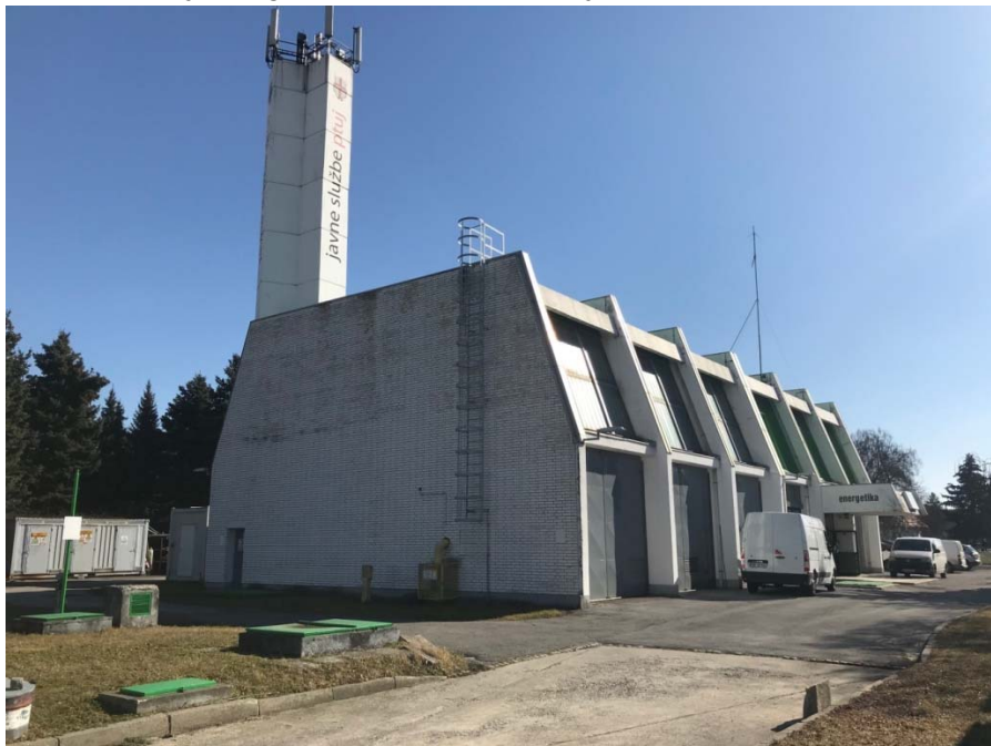
Slika 3: Obstoječa zgradba kotlovnice - zunaj
