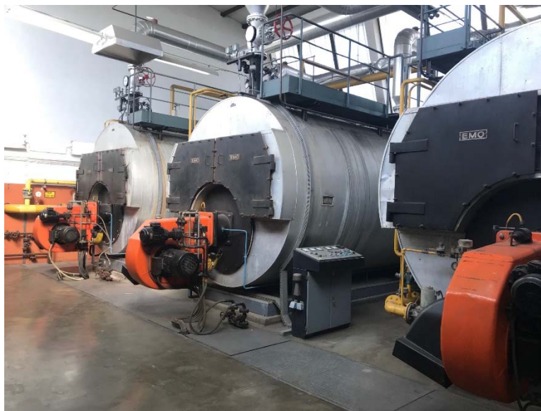
Slika 6: Obstoječe stanje kotlovnice (od znotraj in od zunaj):
