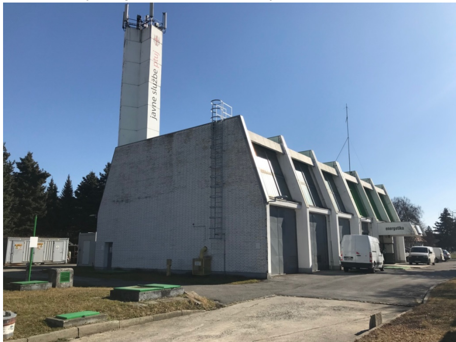
Slika 3: Obstoječa zgradba kotlovnice - zunaj
