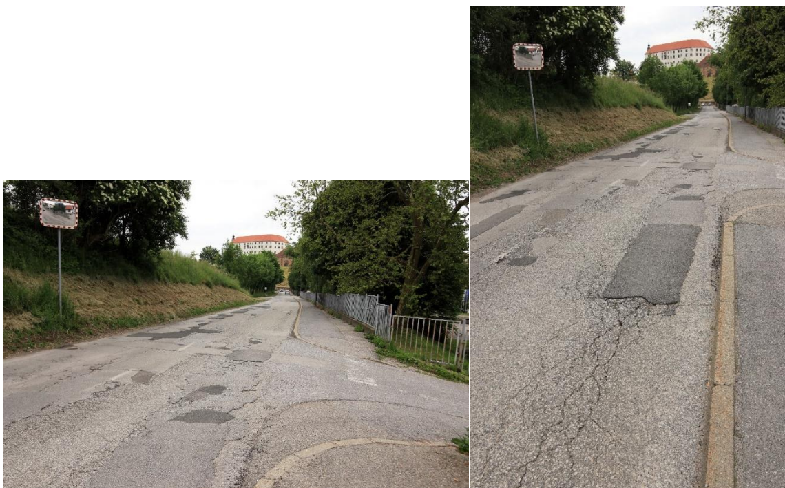
Slika 4: Odsek: Iz smeri Vičave proti Raičevi ulici
