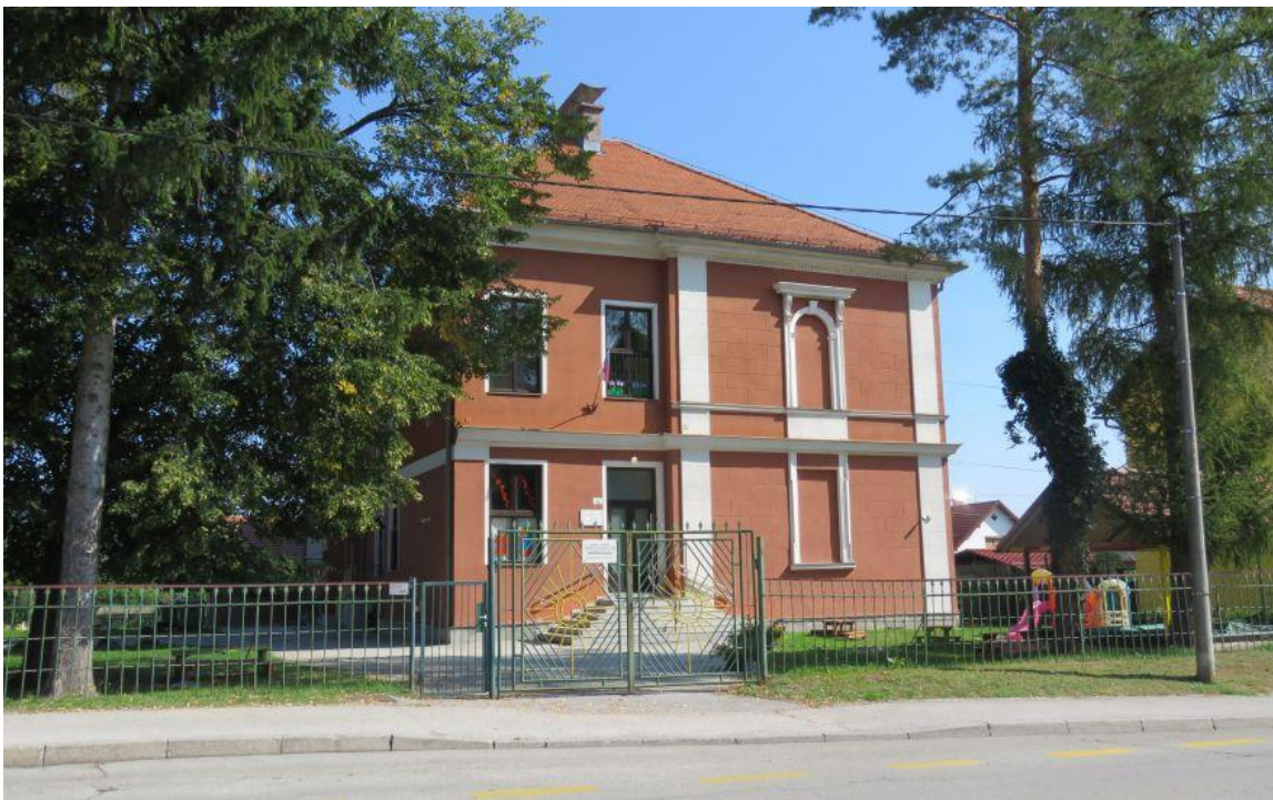
Slika 2: Prikaz vhoda v objekt s cestne strani
